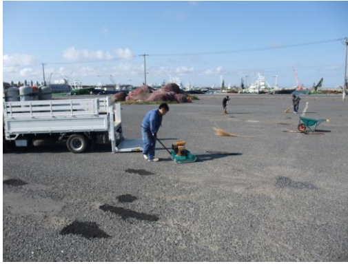
1週間前から会場を清掃し アスファルト補修するメンバー
